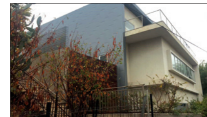
בית ארבע קומות עם כל שיטות הנימור טיח, שליכת צבעוני, אבן וחיפוי יבש של לוחות פלדה. בית הכולל מרתף ועוד שלוש קומות מעל הקרקע בבית שמש
