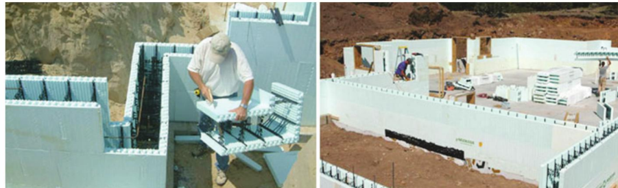
בנייה בשיטת ICF של NUDURA. "אנחנו בפיגור בהשוואה לעולם" / צילום: Eco Build
